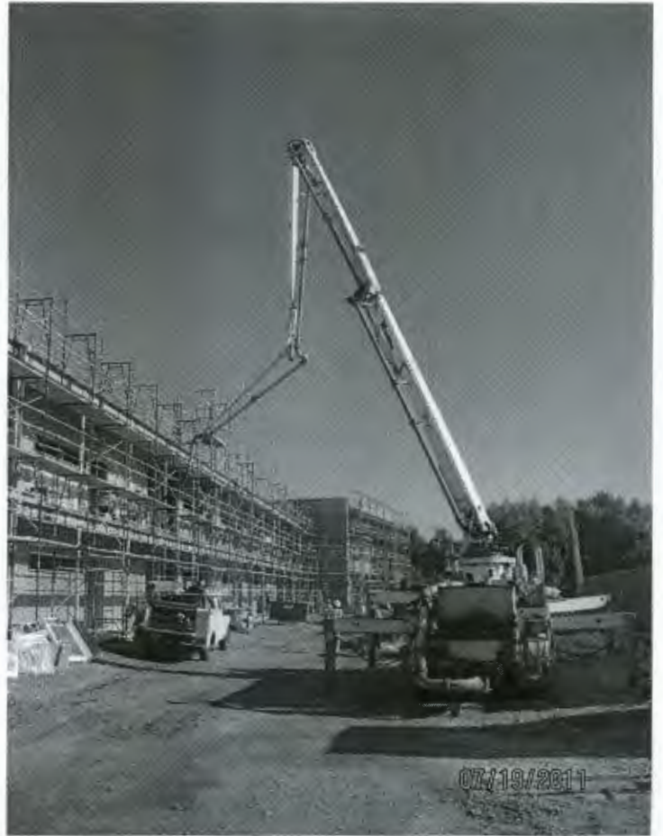
2 ND FLOOR EXTERIOR DECK POUR
